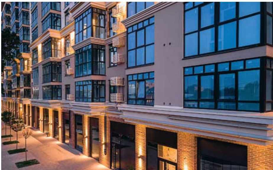
Сложные фасады с архитектурной подсветкой — редкое явление для региональных рынков жилья
