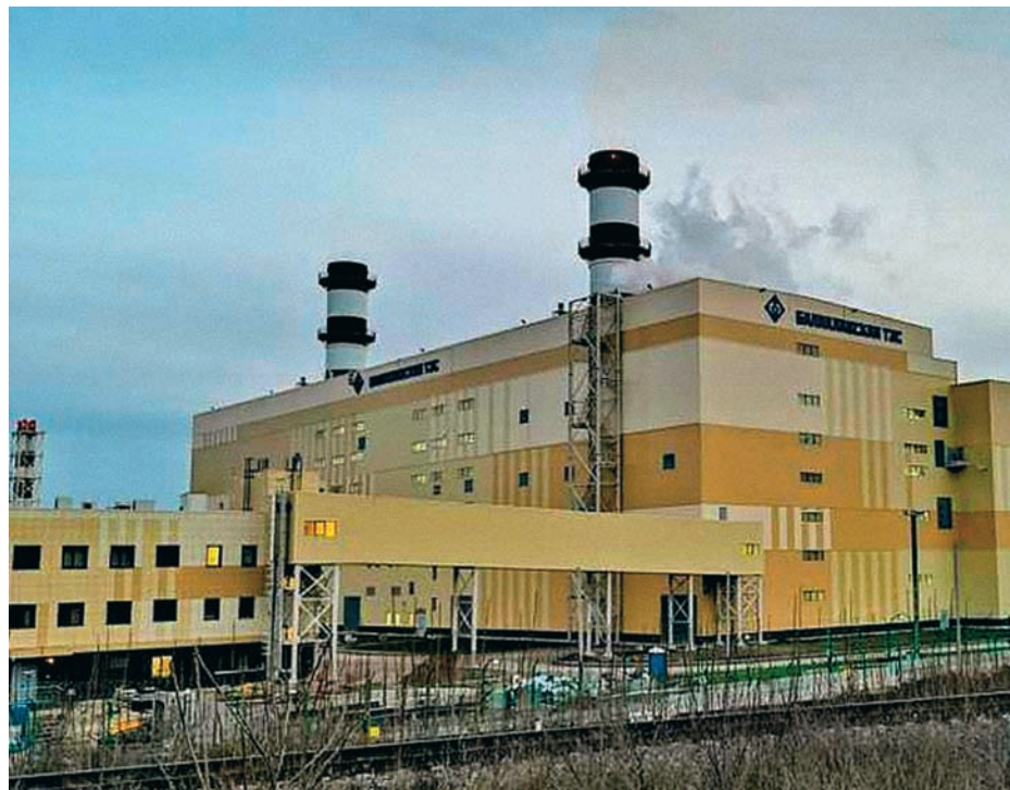
Крымский энергетический гринфилд — парогазовая Балаклавская ТЭС в Севастополе мощностью 497 МВт — пущена в эксплуатацию в 2018 году
