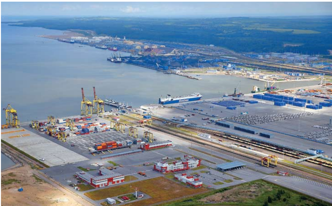
Газохимический комплекс в Усть-Луге (его стройплощадка на фото) — крупнейший проект «Газпрома» по крупнотоннажной переработке природного газа
