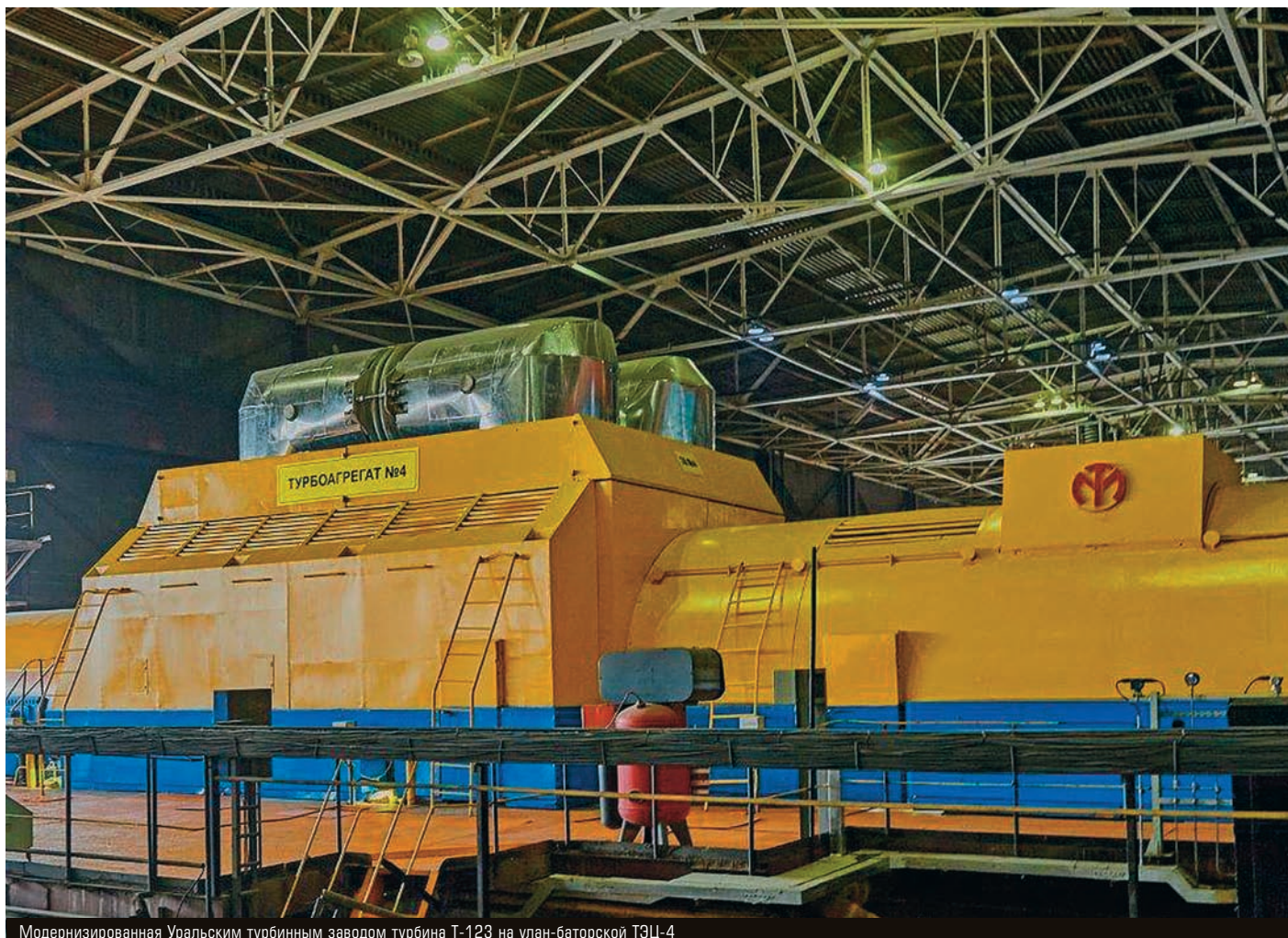
Модернизированная Уральским турбинным заводом турбина Т-123 на улан-батырской ТЭЦ-4
