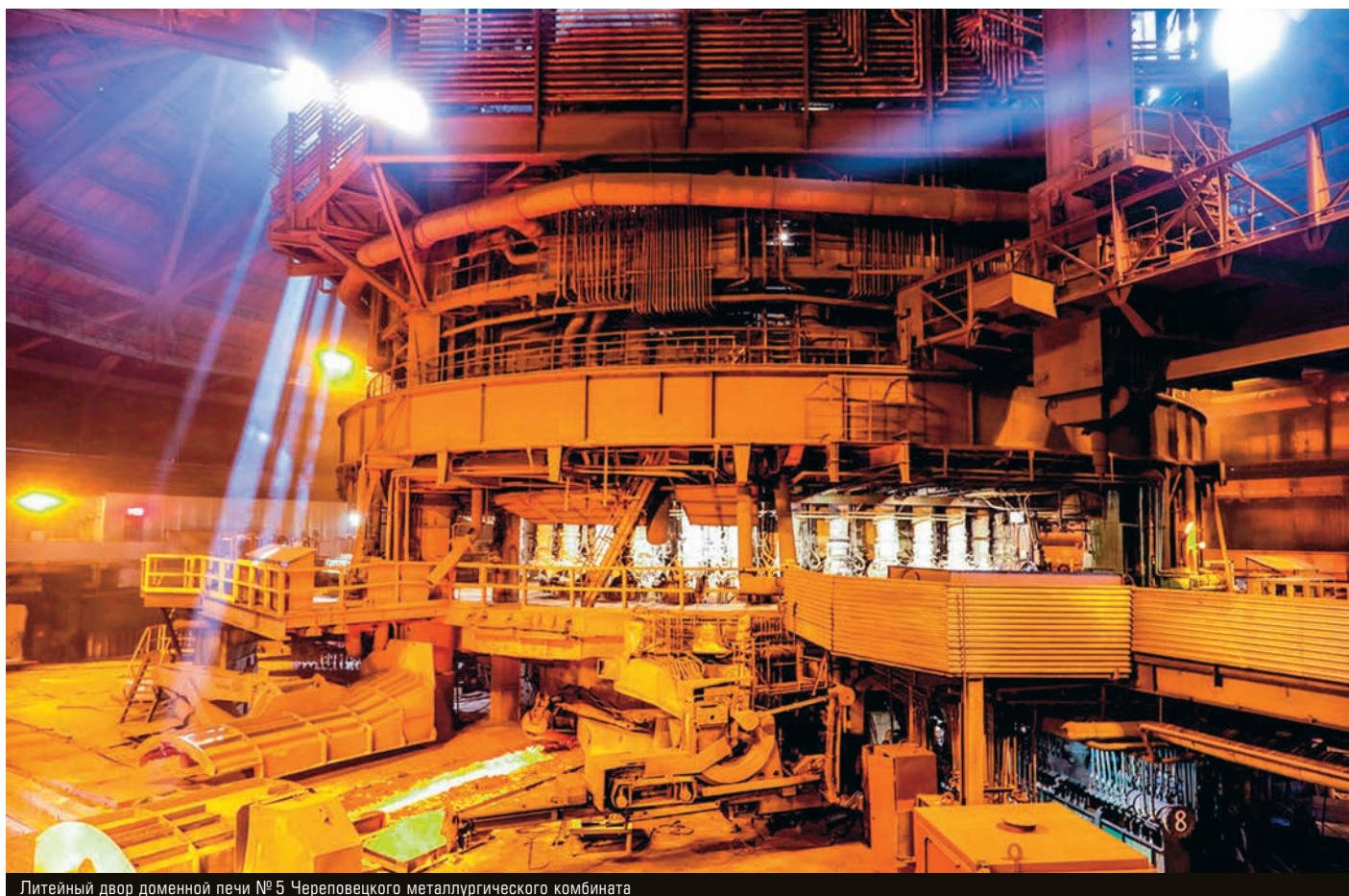
Литейный двор доменной печи № 5 Череповецкого металлургического комбината
