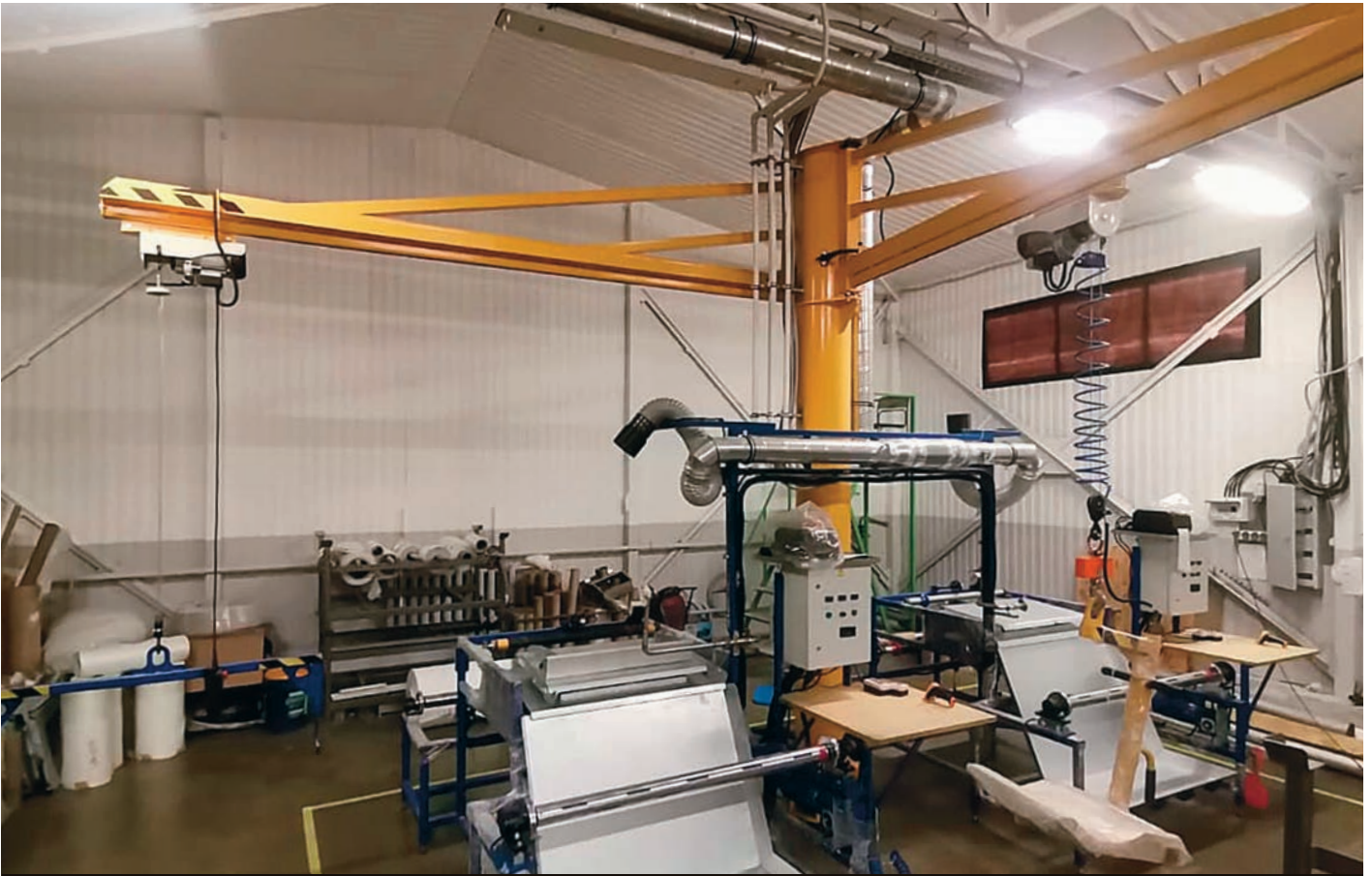
Компания «Полимертехком» за год самостоятельно разработала оборудование и сырье для импортозамещающего производства полимерного рукава, который предназначен для ремонта труб
