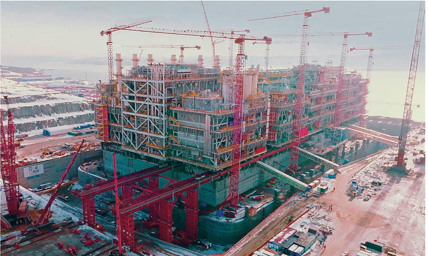
«НоваТЭК» освоил поточное производство технологических линий СПГ-заводов на гравитационных основаниях в своем Центре строительства крупнотоннажных морских сооружений (ЦСКМС) в Белокаменке Мурманской области. На фото: в сухом доке ЦСКМС идет строительство первой технологической линии завода «Арктик СПГ-2». В августе 2023 года готовая линия была отбуксирована в Обскую губу к полуострову Гыдан на место своей постоянной эксплуатации. В ближайшее время она даст первый СПГ
