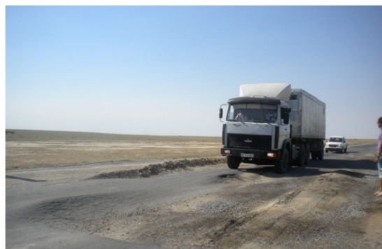
3-сурет – Құлсары-Теңіз трассасындағы жолдың деформациясы (жерлерінің төмендеуі)
