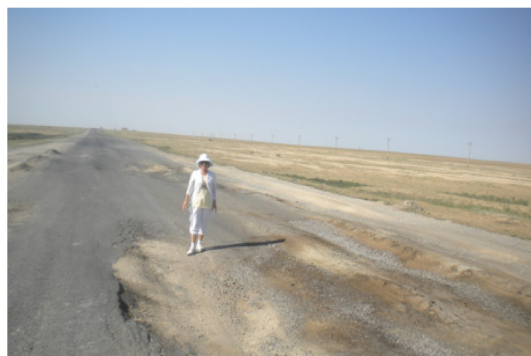
3-сурет – Құлсары-Теңіз трассасындағы жолдың деформациясы (жерлерінің төмендеуі)
